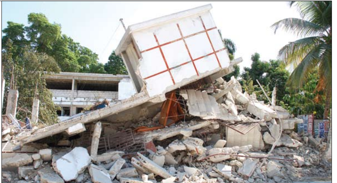
Ce qui reste de l'immeuble du Victorian School
