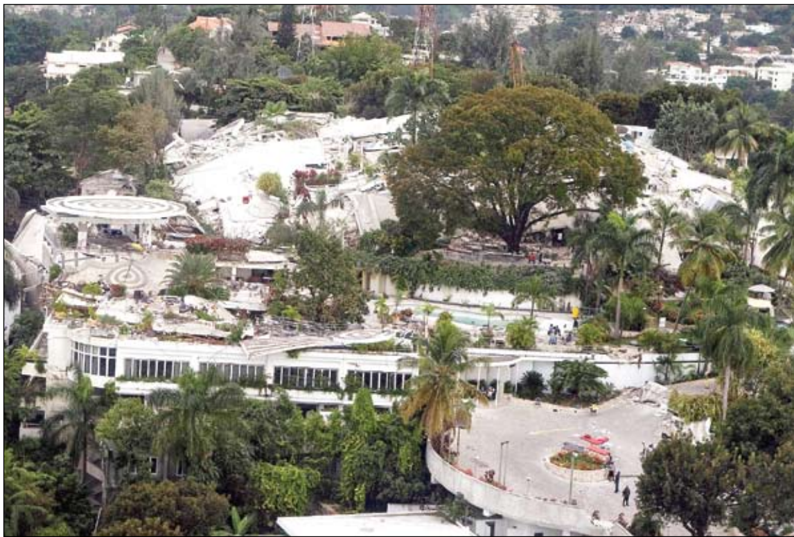
L'hôtel Montana complètement détruit
