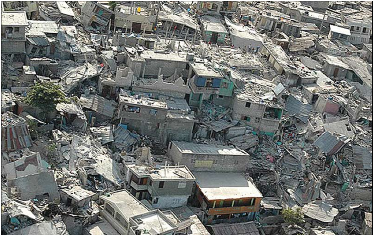
Les secondes les plus longues de l'histoire d'Haïti ont laissé que ruines et destruction. Ces maisons tant aimées se transforment en pièges, en cercueils
