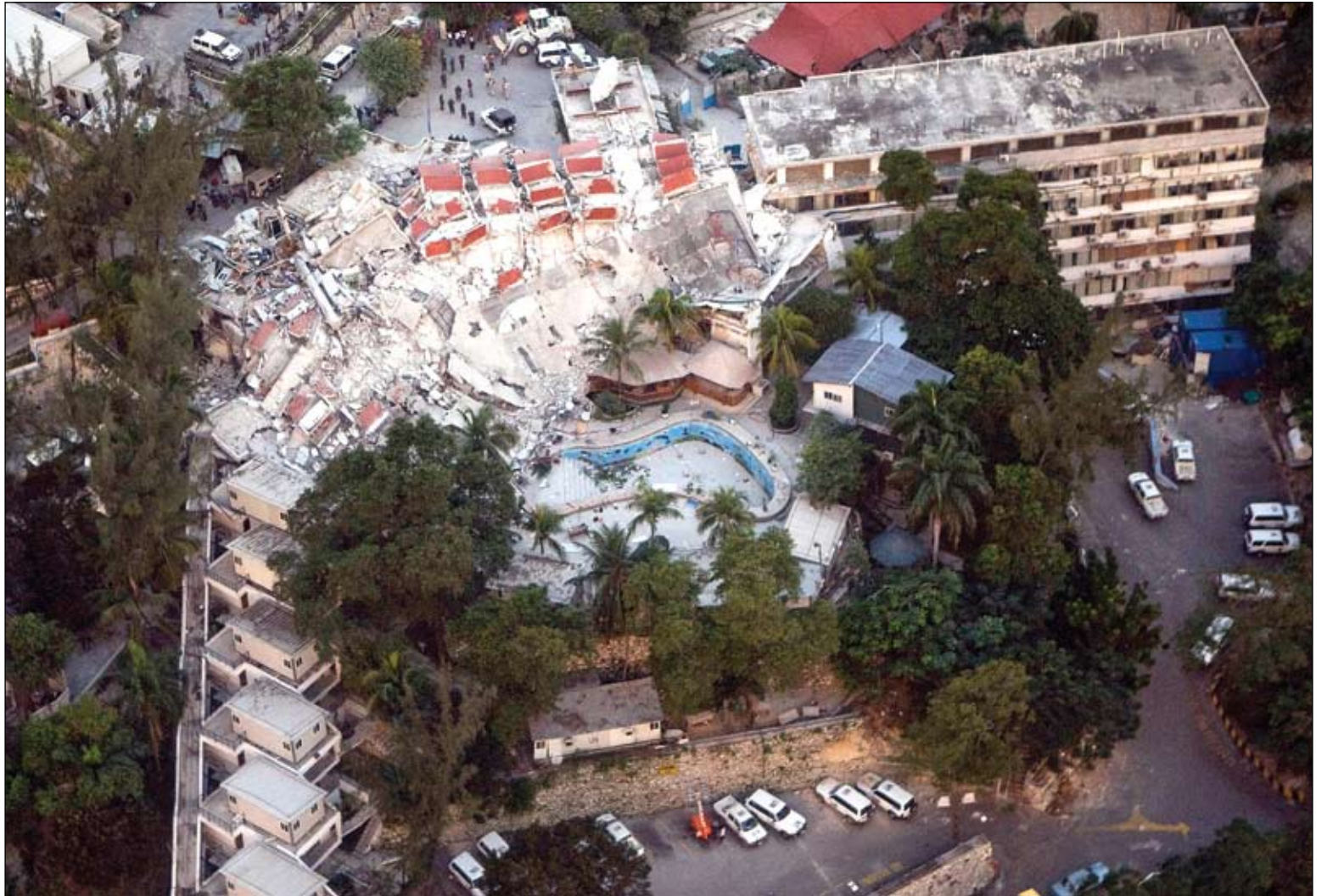
La partie centrale de l'ancien hôtel Christopher à Bourdon, qui servait de quartier général à la Minustah, s'est effondrée le 12 janvier
